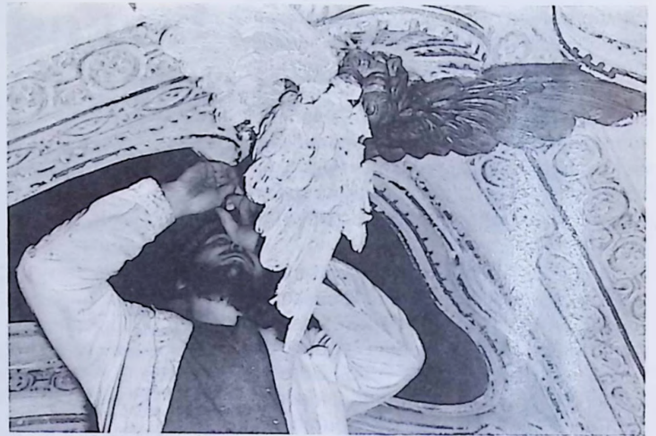
Stiftskirche, Freilegung durch Leimstrappierung der Übertünchung, Abziehen der getrockneten Leimmaske zusammen mit der Übertünchungsschicht
