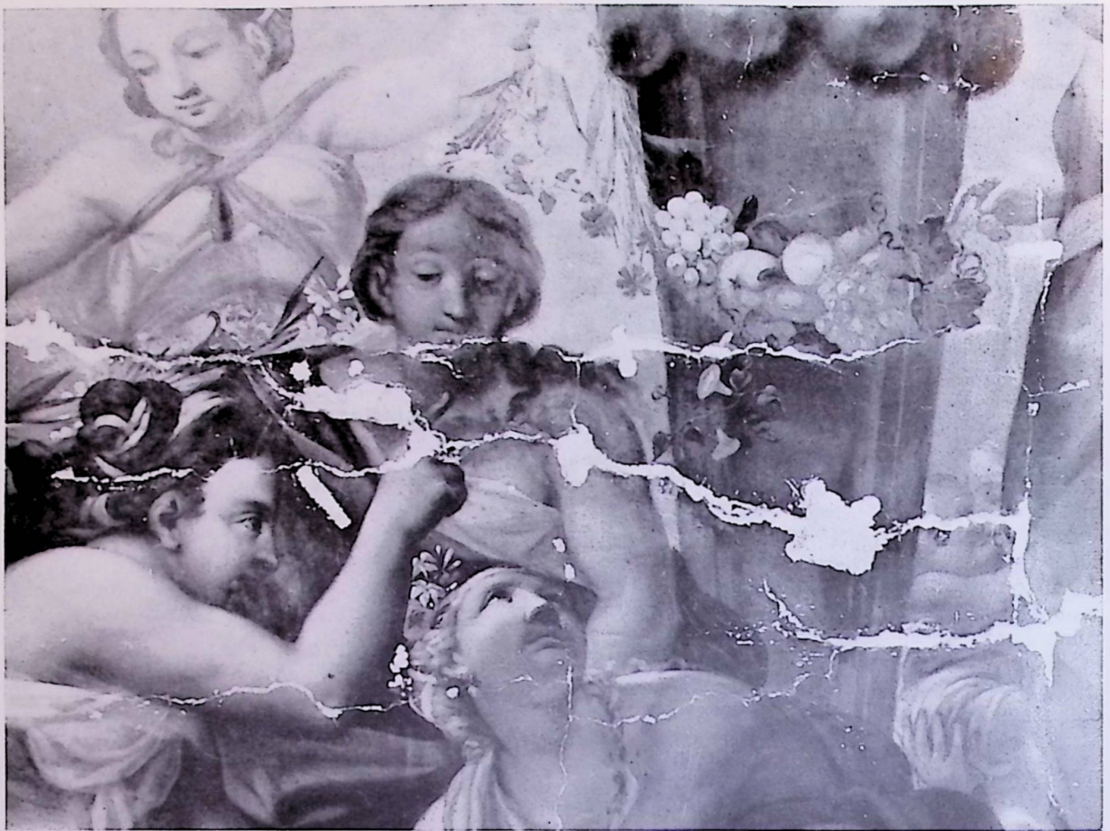
Kaiserzimmer: Gelbes Zimmer, Detail aus dem Deckengemälde „Die Huldigung der Mutter Natur durch ihre Kinder“, verkitete Risse und Putzsicherungen.
