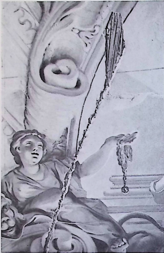
Marmorsaal: Detail aus dem Fresko „Bellona schließt den Kriegstempel“. Ein gefährlicher Riß vor und nach der Restaurierung.
